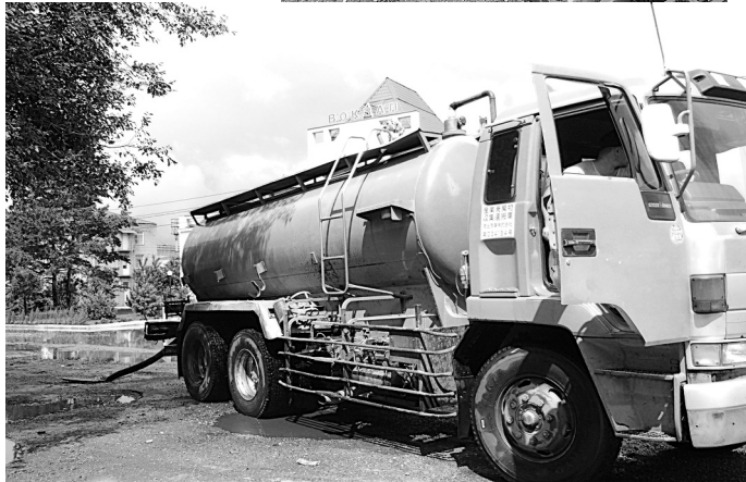
Ремонт ливневой канализации на ул. Победы
