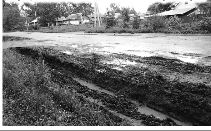
Обустройство водоотводных канав на ул. Рябухи
