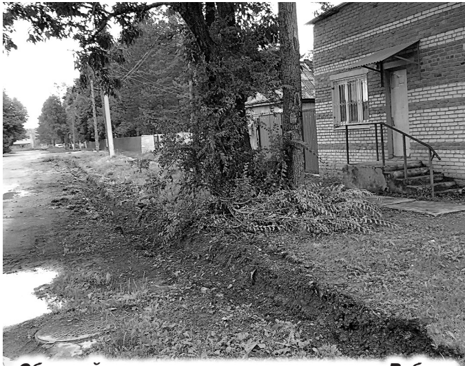
Обустройство водоотводных канав на ул. Рябухи
