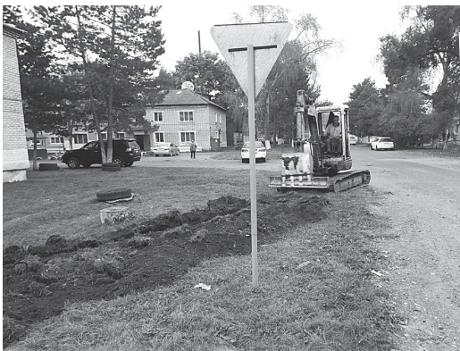
На снимках: устройство водосливных кюветов на ул. Серышева. Помощь оказывает ИП Станислав.
